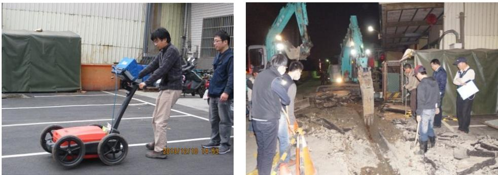
圖 4-8 專案人員以透地雷達確認暗管位置，再動用重機械開挖
