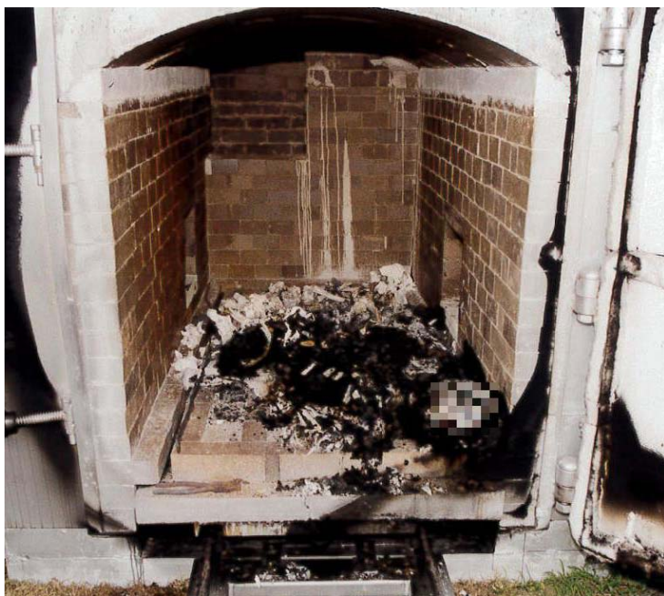
焚化爐內發現白骨
